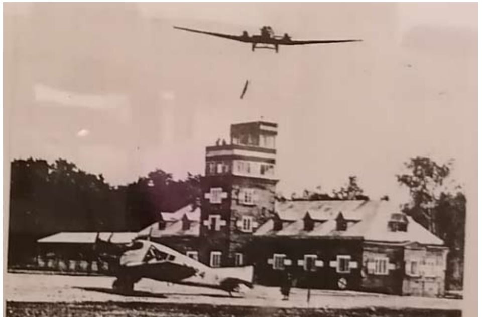
Das Flughafengebäude auf dem Dresdner Heller im Jahre 1926 mit einer Junkers F13 und einer Junkers G23. Foto: Archiv Hellersiedlung
